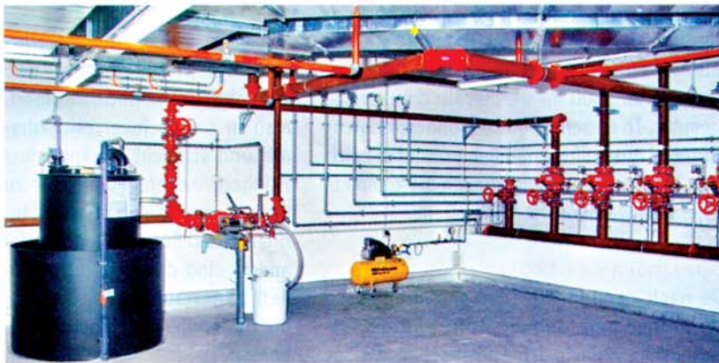
Die Sprinklerzentrale – das Herzstück des Systems
