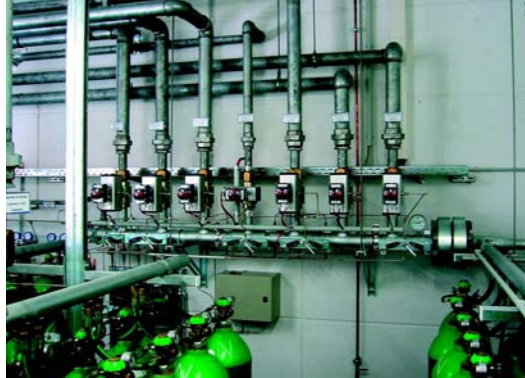
Bereichsverteiler ARGONITE®
