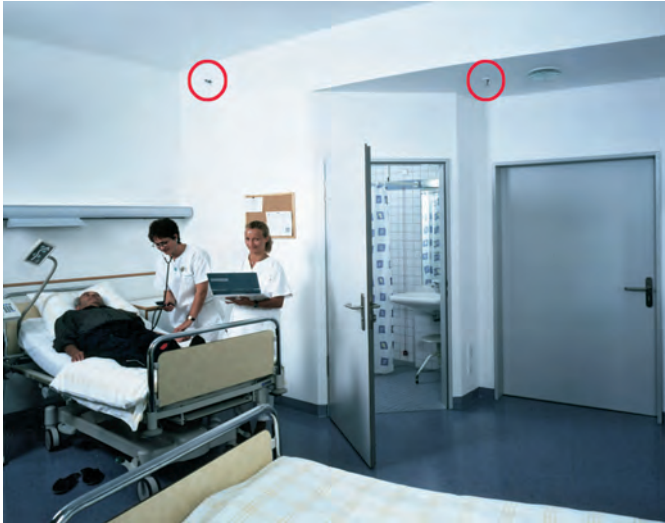
Bild 2. Vollflächiger Sprinklerschutz in großen Krankenhäusern (KKH Freiberg)
